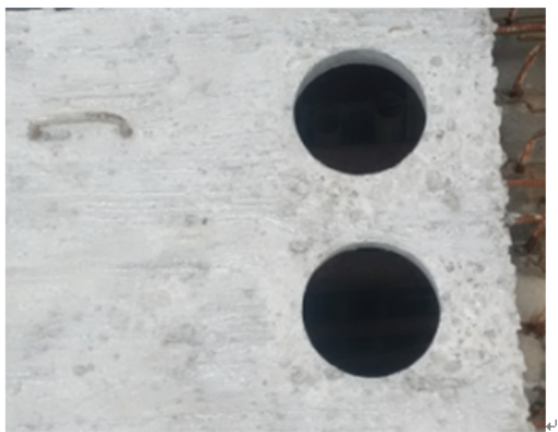
预制楼盖公共部分消防管道预留洞口
