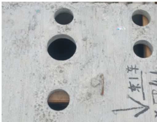
预制楼盖的管道井内给排水洞口预留
