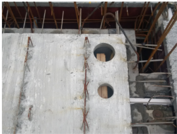
阳台排水洞口预留
