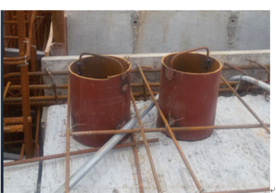
公共部分内消防给水套管续留
