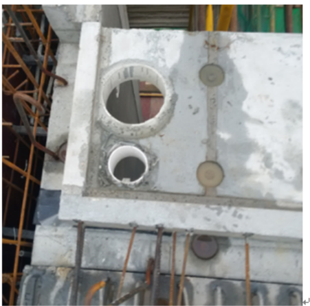
空调板排水洞口预留
