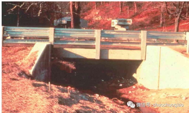
图 1 板梁(Slab)
