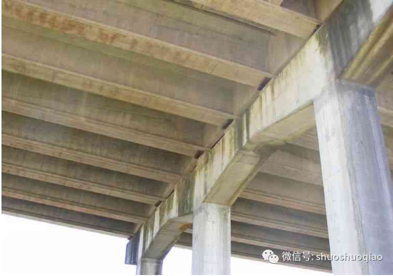
图 2 纵梁/多主梁(Stringer/Multi-beam or Girder)
