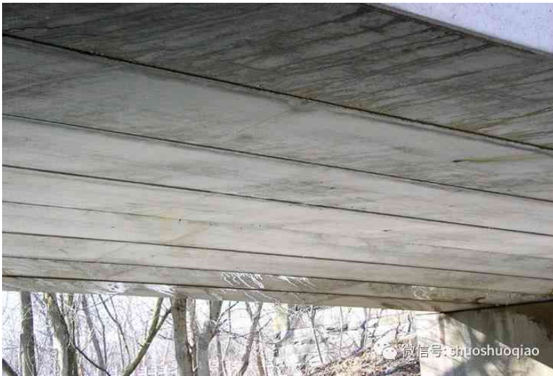
图 5 多箱梁(BoxBeam or Girders – Multiple)
