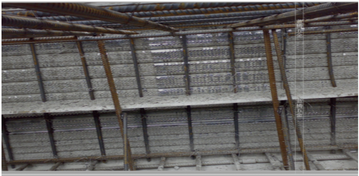
后浇带快易收口网底板做法示意图
