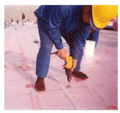
4. 预铺防水卷材:将聚氯乙烯耐根穿刺防水卷材按弹线掌握位置布置在保温层上,卷材铺设方向与压型钢板波浪方向垂直,把自然疏松的卷材按轮廓布置在保温层上。卷材保持平坦顺直,不得扭曲,搭接宽度 120MM,并进展适当的剪裁。
