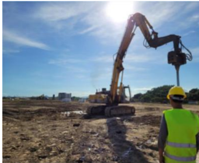
图 5.2.2.1 引孔排障施工
