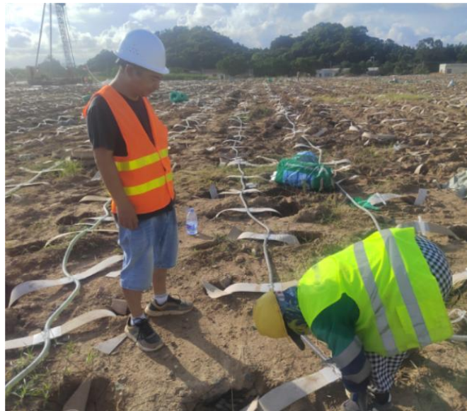
图 5.2.6.1 真空管路连接
