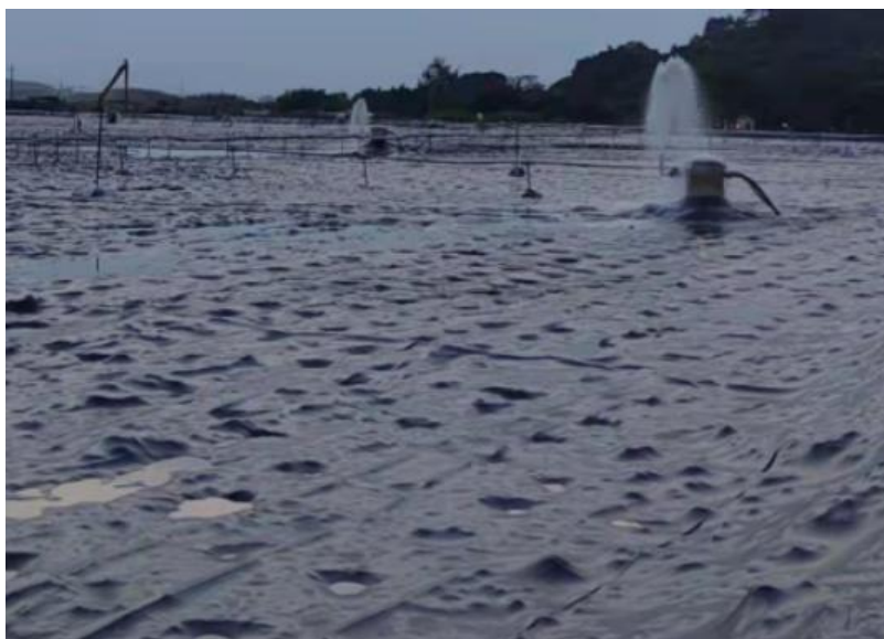
图 4.3.1 适应 25cm 局部高差的密封体系实景
