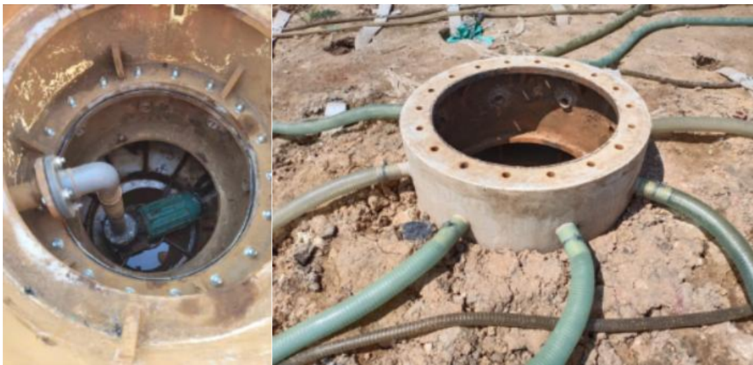
图 5.2.5.2 水气分离罐内景
