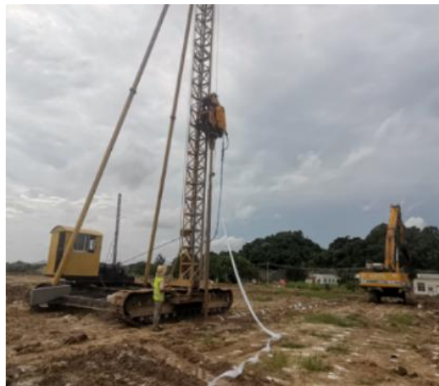
图 5.2.3.1 塑料排水板打设施工
