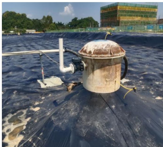
图 4.3.3 水气分离罐与膜下真空管关系
