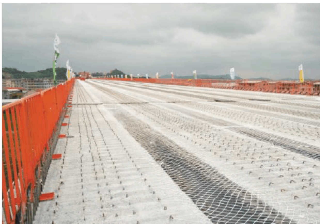
图 4.2-23 水平防坠网示意图
