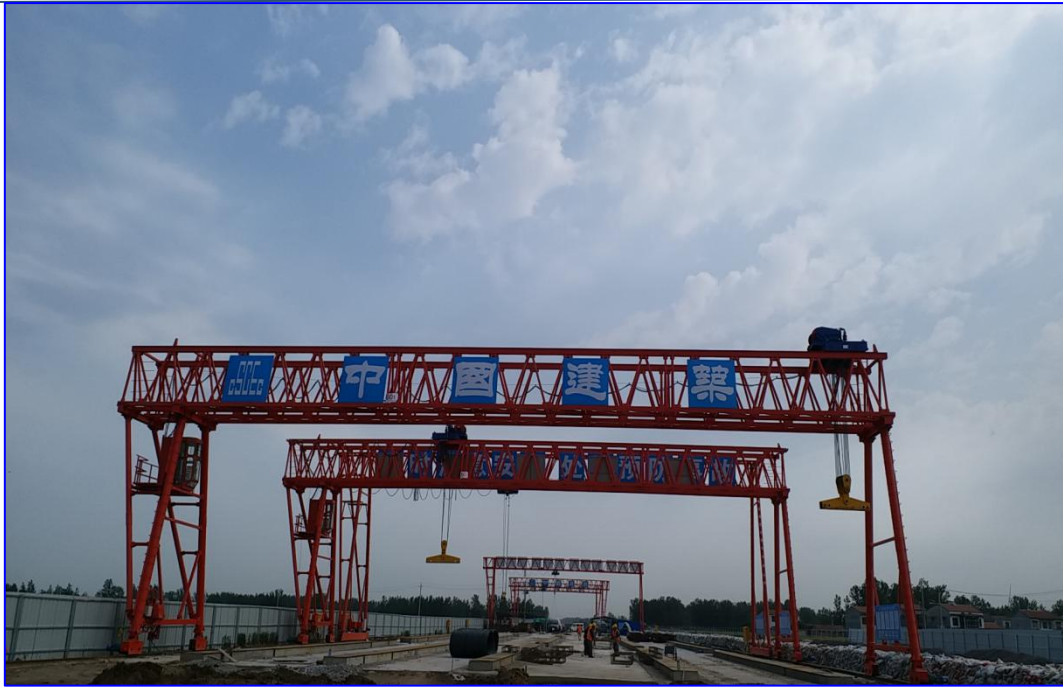
图 2.2.1-2 梁场现场实际情况
