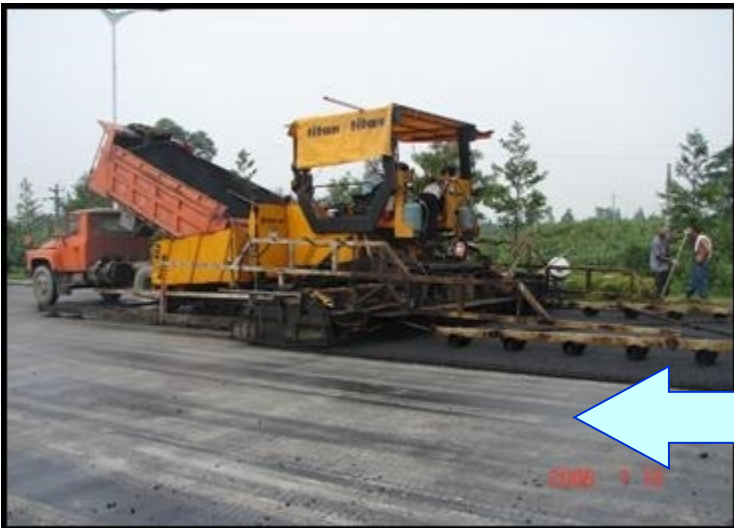
沥青混合料的摊铺
