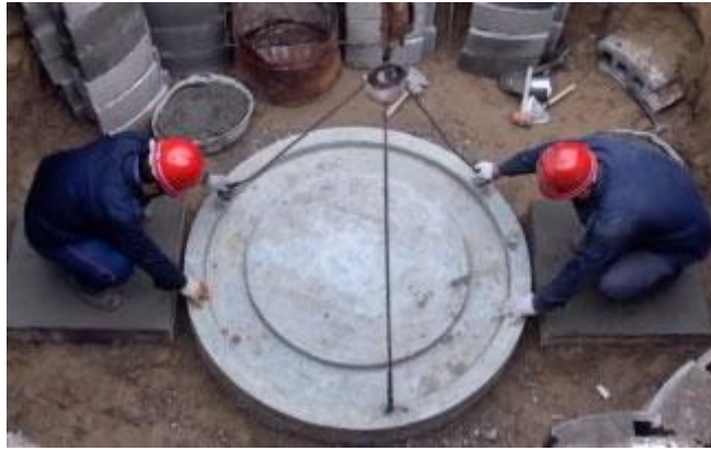
图 5.2.3 预制检查井底座吊装
