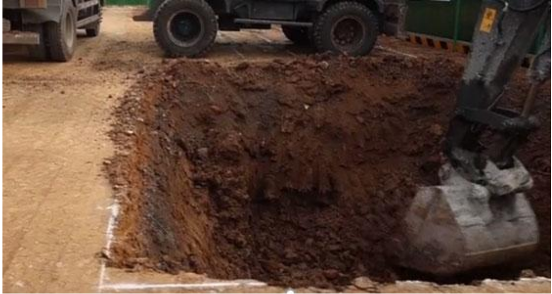
图 5.2.2 基槽开挖
