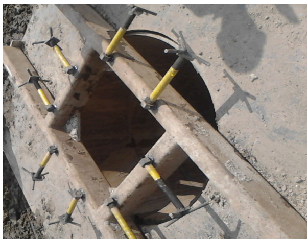
图 5.2.1-2 现场调垂架照片
