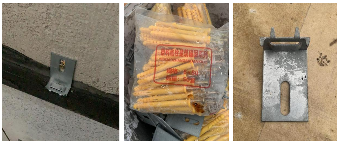
图 5.5.3-1 锚固件的安装 图 5.5.3-2 锚固件套件 图 5.5.3-3 角码
