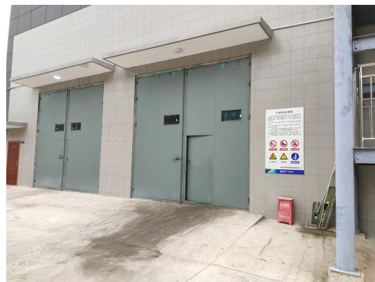
图 4-9 医废暂存间外部
