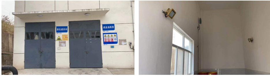
图 4-7 废机油暂存间
