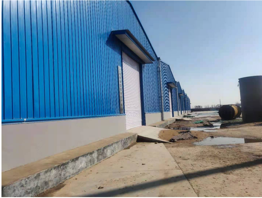
图 2.3.1-2 小型预制构件厂现场照片
