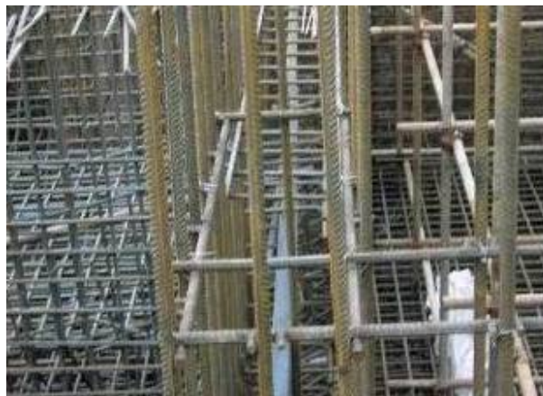
插图 3.3-2 剪力墙设置梯子筋
