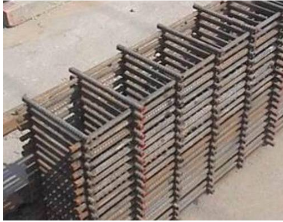
插图 3.3-1 剪力墙用梯子筋
