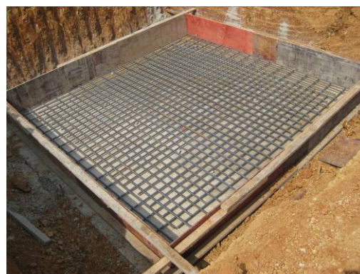
承台钢筋绑扎
