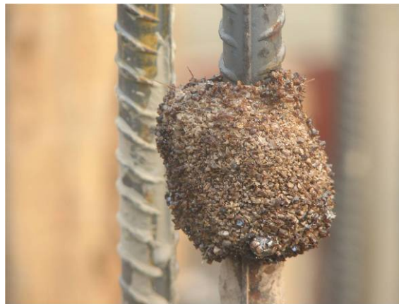
插图 2.4-8 焊包保温后及时清理
