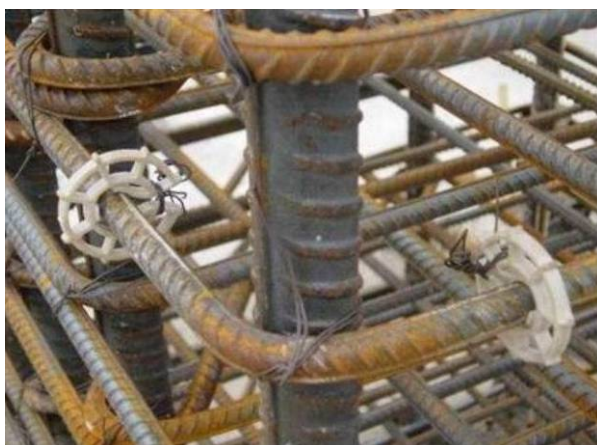
插图 2.2.2-7 设置保护层垫块
