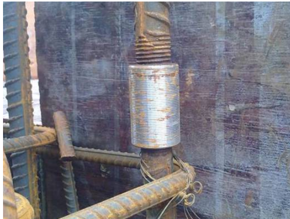
插图 2.4-9 直螺纹外露丝扣过多
