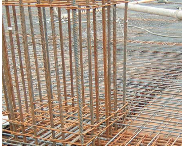
插图 2.2.2-4 预留钢筋上套箍筋
