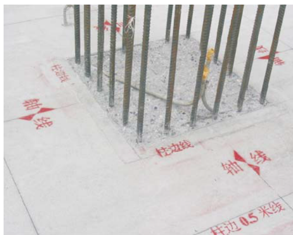
插图 2.2.2-1 画出柱定位线
