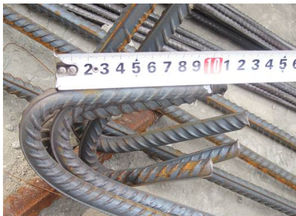
插图 2.4-5 箍筋弯钩平直段长度不足
