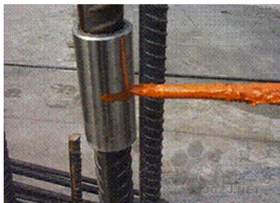
插图 2.4-11 对已拧紧的接头进行标识
