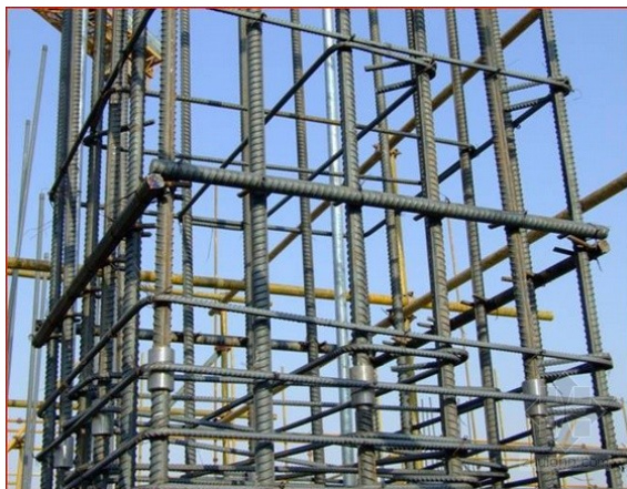
插图 2.2.2-5 柱竖向钢筋连接
