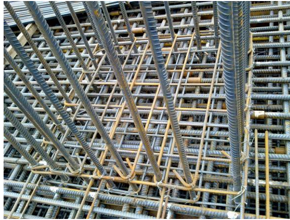
插图 2.4-3 绑扎定位箍筋
