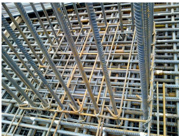
插图 2.2.2-2 柱端设置定位箍筋
