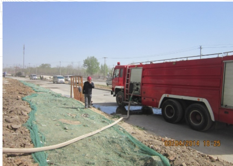
水泵接合器测试
