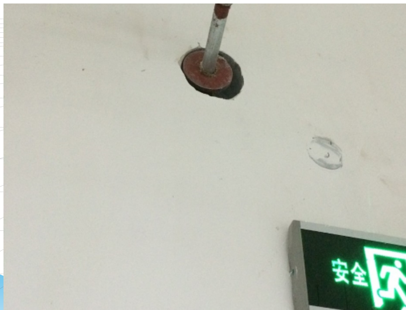
穿人防维护构造孔洞
