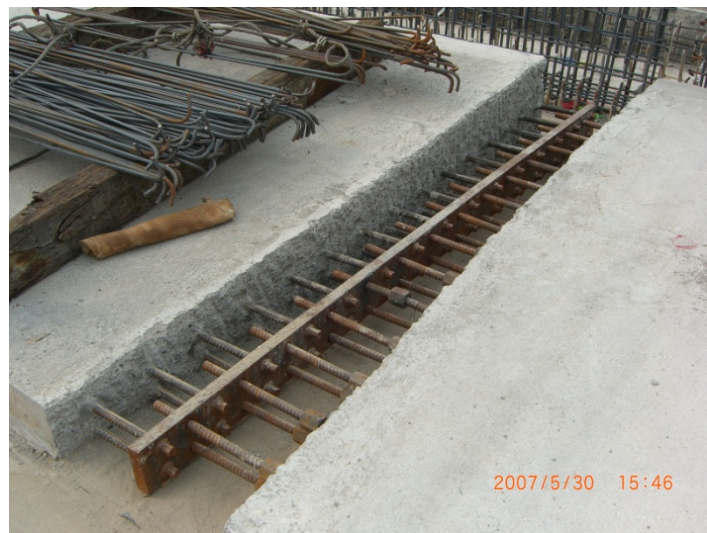
图 14 两个混凝土浇筑段之间的钢板连接器后浇带 BL1
