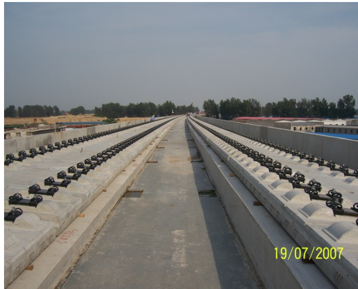
图 1 上面粗铺轨道板的浇筑完成的底座板
