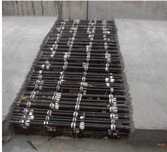
图 15 齿槽后浇带 BL2
