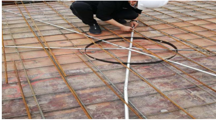
图 5.2.5-1 叠合连接器定位
