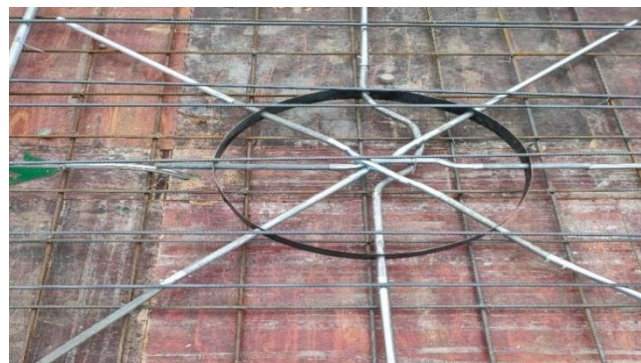
图 5.2.3-1 叠合连接器定位
