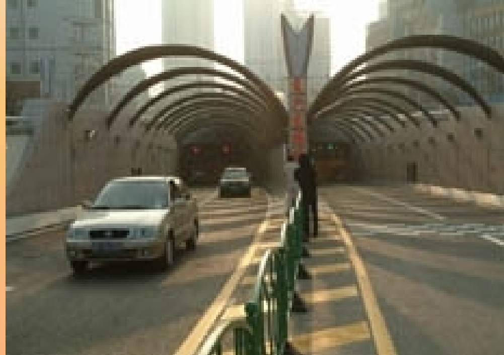
复兴东路双层隧道↑
