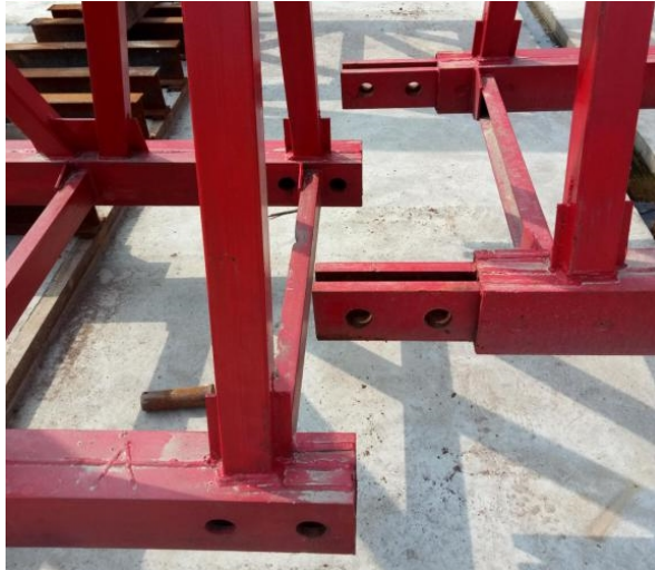
图 6.3.1 龙门吊构件地面组装
