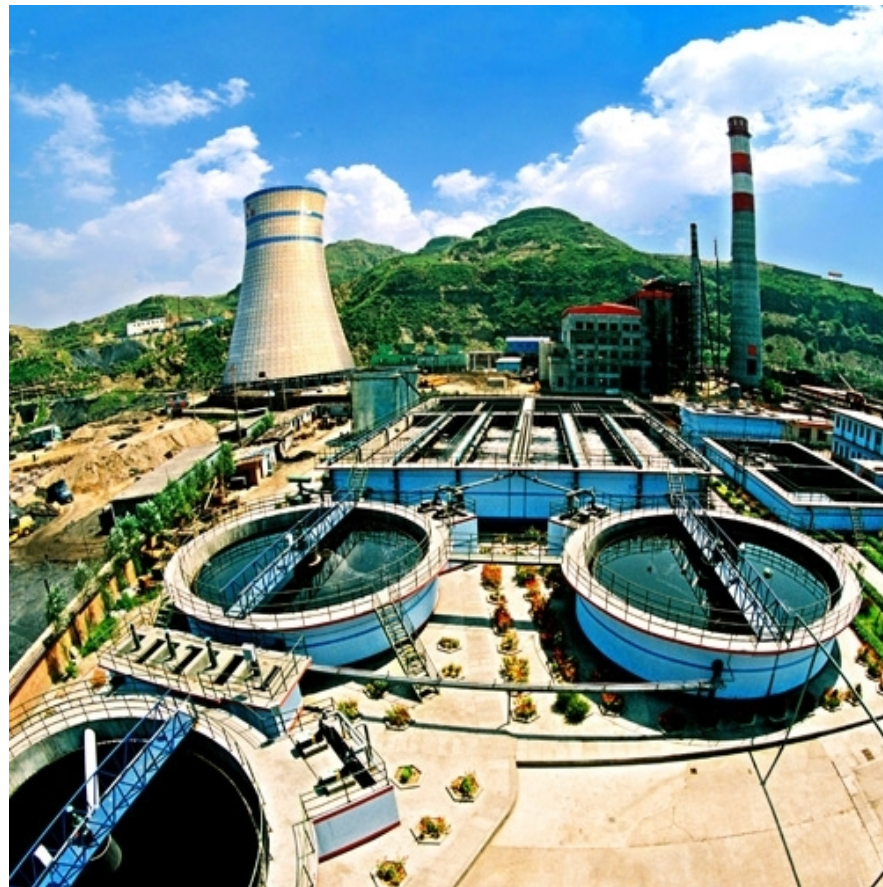
建污水处理厂，污水达标排放
