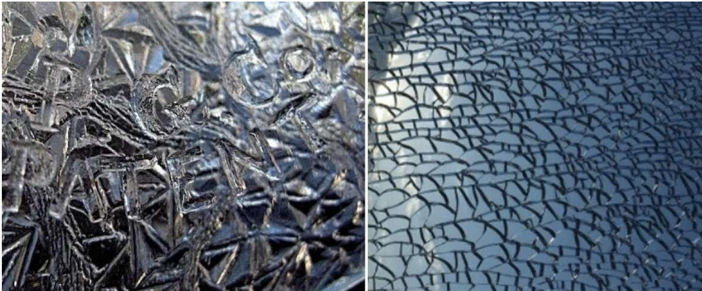
图 4-77 冰花玻璃和钢化玻璃裂纹
