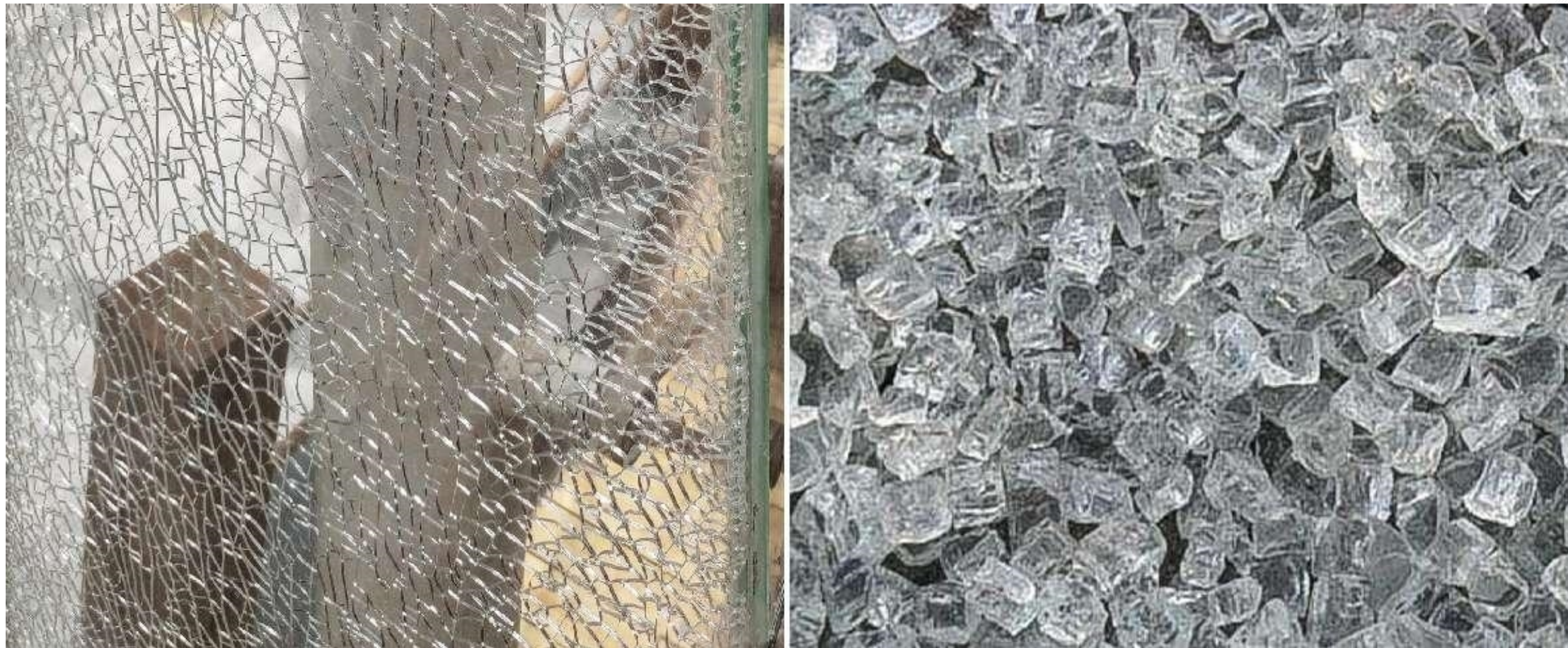
图 4-80 钢化玻璃开裂及碎裂
