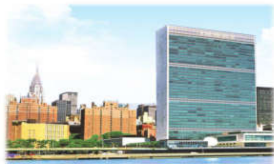
位于美国纽约的 联合国总部大楼
