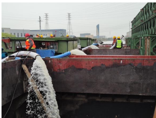
图 5.2.4-9 驳船支架体系压水
