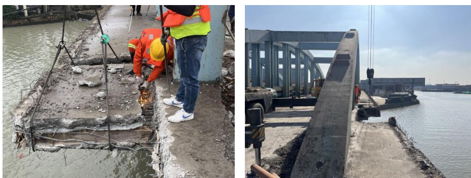
图 5.2.2-1 拆除人行道现场图
