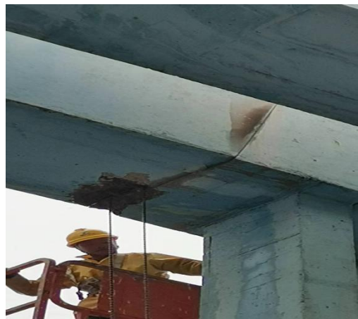
图 5.2.6-2 体系转换拱肋切割现场图（二）
