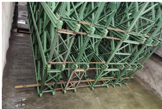
图 5.2.4-5 贝雷与船底固定现场图
