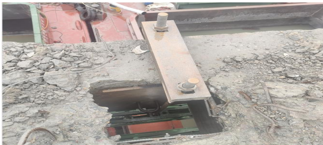
图 5.2.4-6 贝雷与系梁固定现场图
