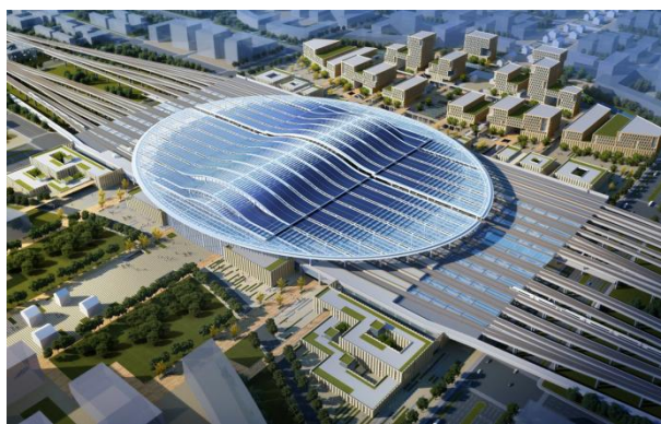
图2：公司承建雄安新区城际铁路雄安站站房支持与桩基工程
