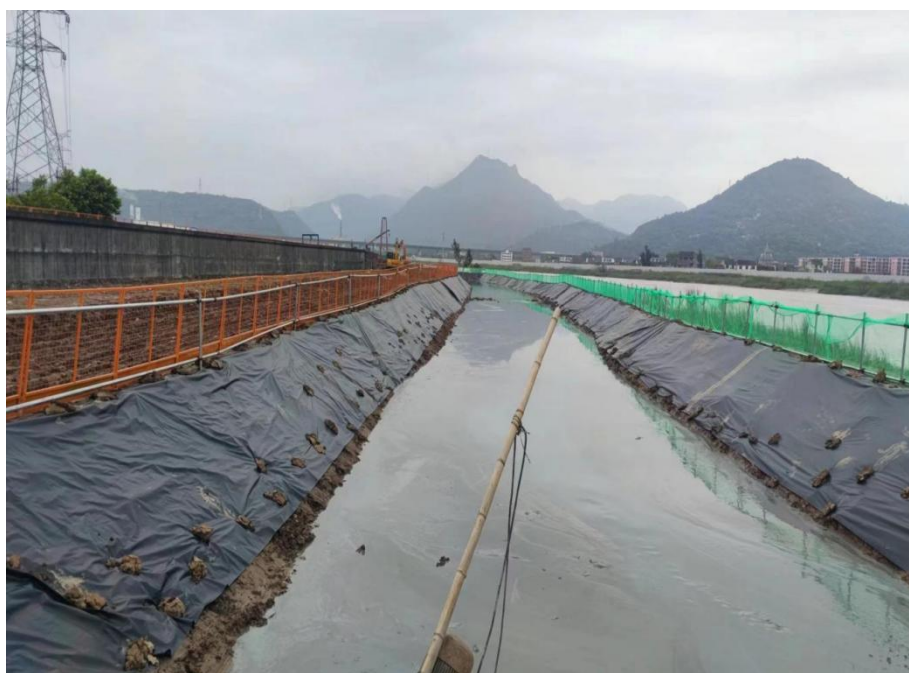
图 5-7 泥浆池铺设防渗土工膜-2
