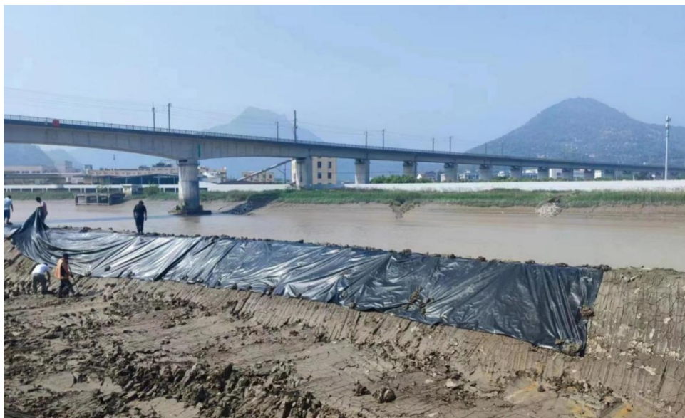
图 5-6 泥浆池铺设防渗土工膜-1
