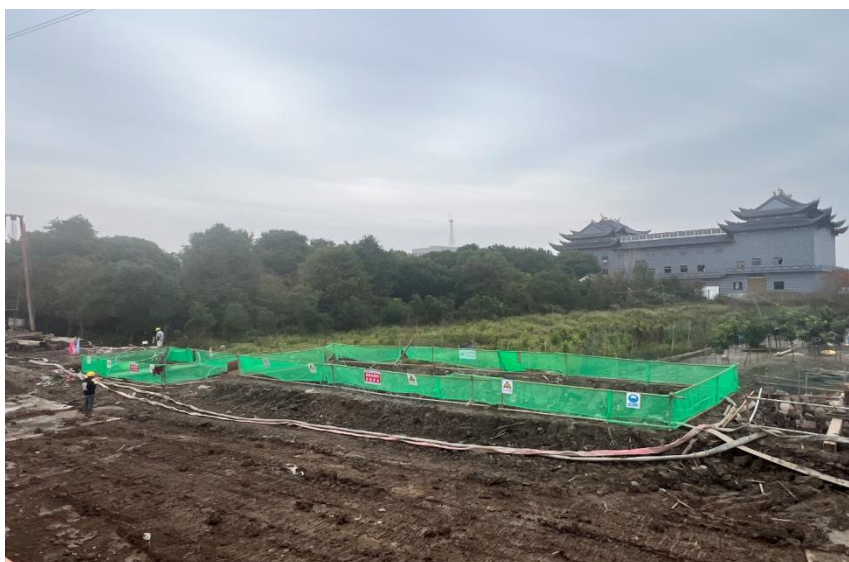
图 5-10 安装泥浆管
