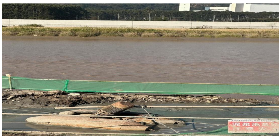
图 5-12 安装泥浆抽取设备-2
