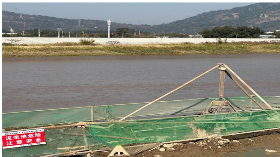
图 5-11 安装泥浆抽取设备-1
