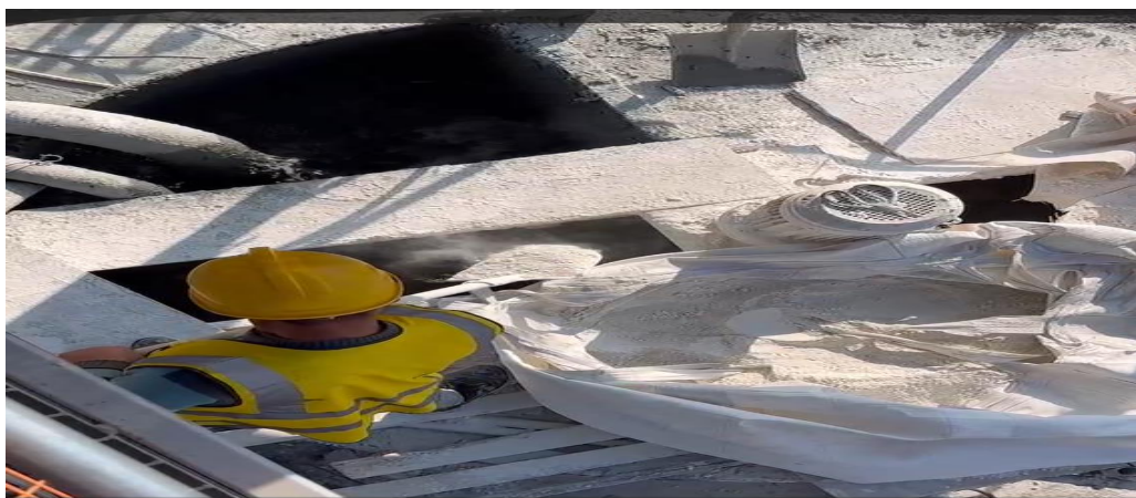
图 5-13 泥浆过滤及添加固化剂
