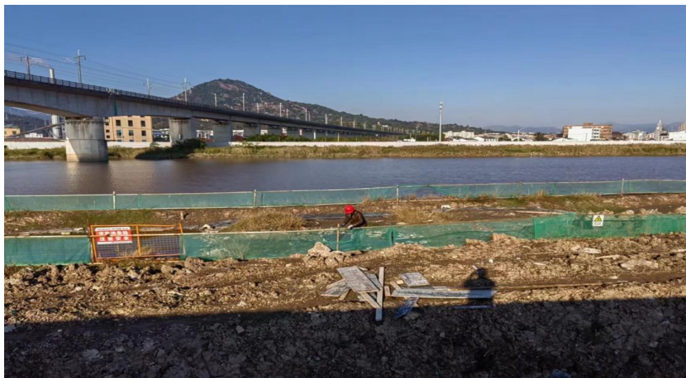
图 5-9 泥浆池周边设置防护设施
