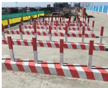
图 3.2 混凝土加槽钢组合条墩
