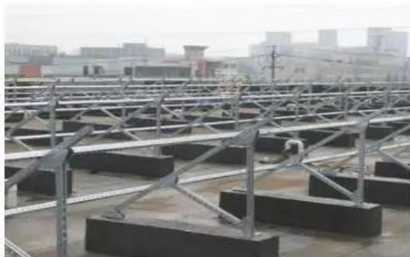
平顶屋面条形混凝土基础支架
