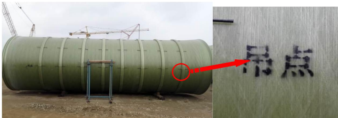
(a) 管道上吊点标识
