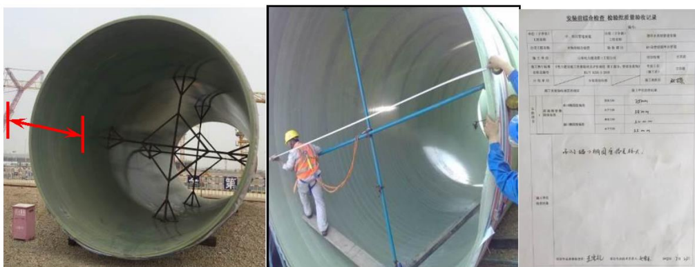
(a) 管道到货时内部支撑 (b) 现场测量 (c) 现场测量记录
