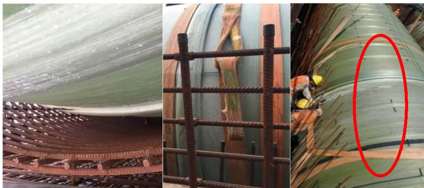
(a) 管道与钢筋距离 (b) 缠绕吊带 (b) 拉紧对口
