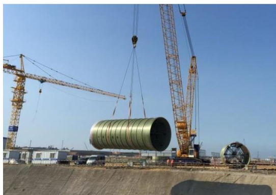
(b) 管道吊装平稳，无倾斜
